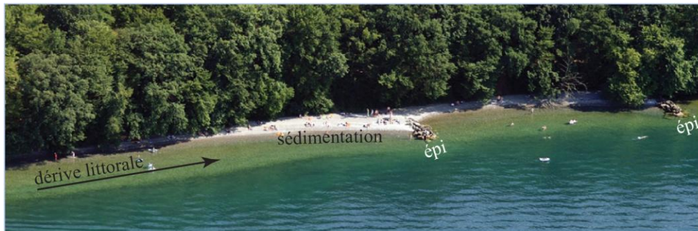
Photo 3 (été 2004, cliché de la CIPEL) : La mise en place d'épis, en contraignant le transit sédimentaire par la dérive littorale, favorise le dépôt de sédiments à leur amont. Ainsi, pour faciliter la redistribution sédimentaire, entravée par de nombreux obstacles, deux épis ont été supprimés en octobre 2018 :
