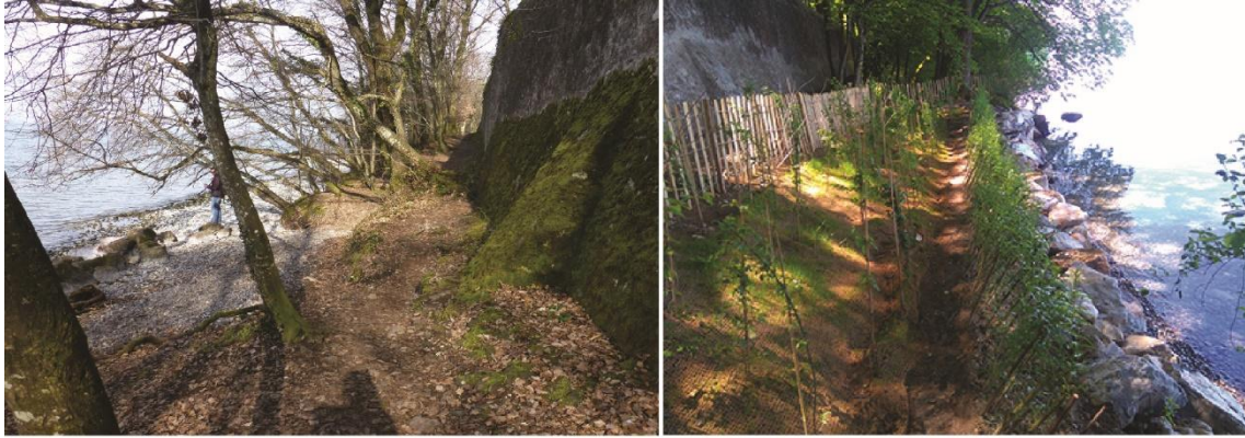
Photos 1 et 2 (mars 2014, cliché Véronique MALEVAL ; mai 2017, cliché Pierre-Briec DESTOMBES) : En contrebas du mur de Ripaille, le littoral lacustre recule (l'encoche d'érosion se rapproche progressivement de la base du mur), par le fait, essentiellement, de l'érosion mécanique des vagues (V. MALEVAL et al. , 2016). Ce tronçon a fait l'objet d'une réhabilitation par renaturation sur un linéaire de 17 m, et aujourd'hui, il présente un enrochement végétalisé à sa surface par des espèces d'arbres, de graminées et de fleurs, adaptées aux milieux hydromorphes ; le développement des racines doit favoriser le maintien de l'ouvrage et, par conséquent, du littoral.
